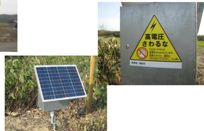
また、電牧柵を稼働させるために「ソーラーバッテリー」も設置していますが、このボックス自体にも電流が流れていますので、電線と合わせて、ボックスにも触れないようご注意ください。
