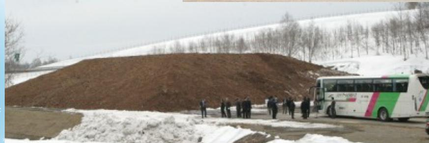
バーク材で覆うことで1年中雪が利用可能な「沼田式雪山センター」雪山を重機で切り崩し、ダンプカーなどで雪を供給しています。
