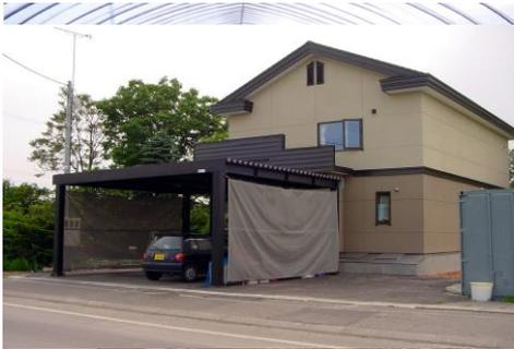
雪冷房住宅(貯雪庫は地下に設置)
