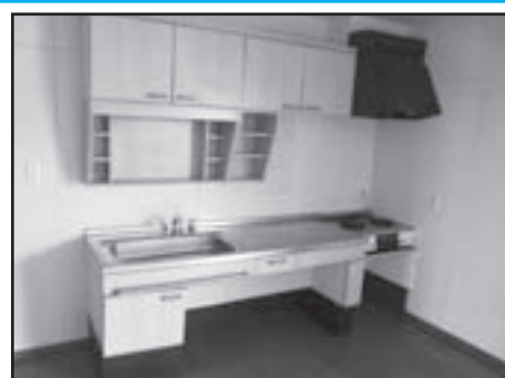
車いすに対応したキッチン
