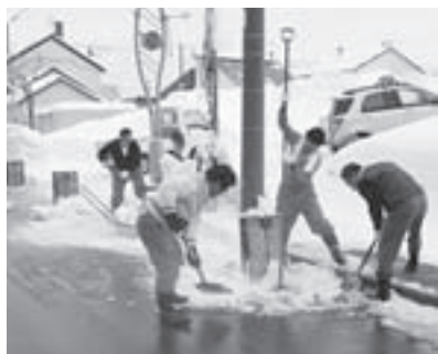
市街地を融雪溝を利用して除雪する宮脇大木建設株式会社
