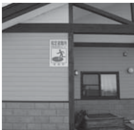
平成19年10月各避難所に避難所標識を 設置しました。
