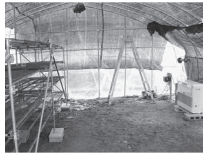
しいたけハウス内部
