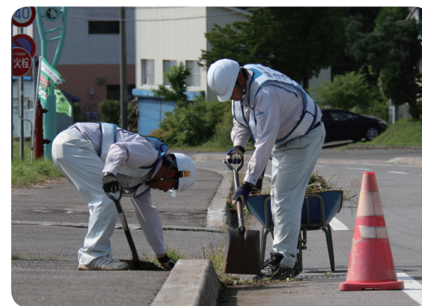
▲丁寧に作業していただきました
