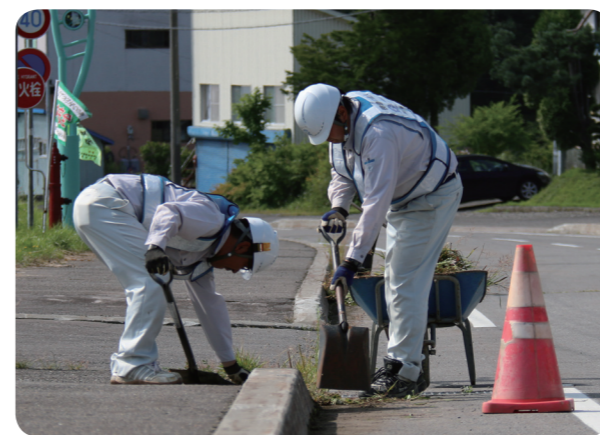
▲丁寧に作業していただきました
