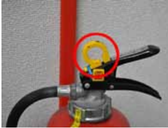
ピン・レバーの破損
