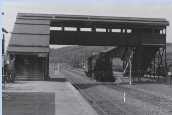
▲恵比島駅跨線橋
