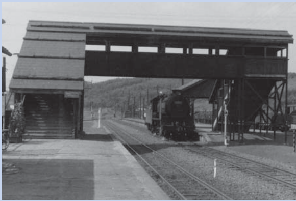
▲恵比島駅跨線橋
