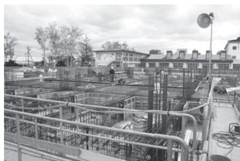
工事現場内部の足場から撮影。
