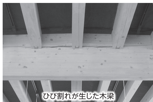
2017年にひび割れた原因は天然木材の集成材であり、ばらつきや乾燥によるヒビも多少はあるものの使用に問題が無いことを確認され、樹脂アンカーによる修繕で強固なものになったと判断
