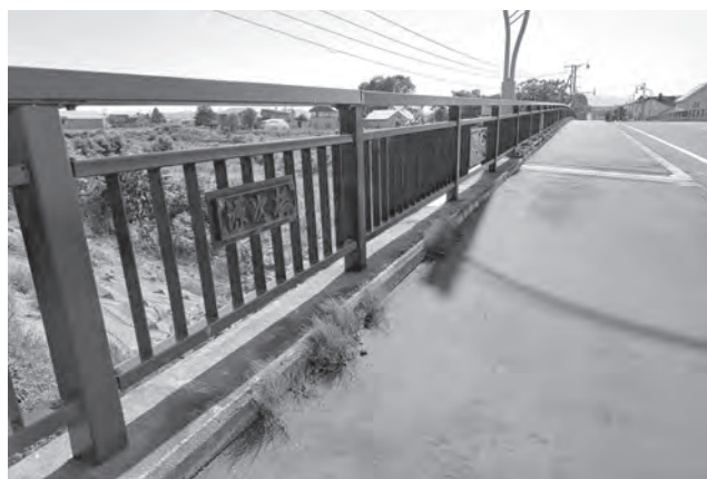
補修中の源次橋
