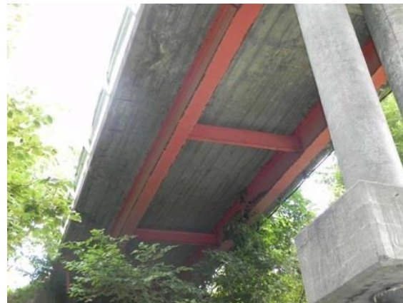
4043 堰堤橋 (橋長 27.00m、1971年架設、43年経過)
