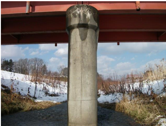
4038 高穂2号橋 (橋長 35.00m、1972年架設、42年経過)
