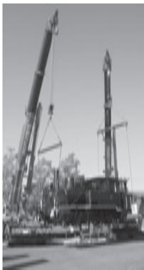
①高架クレーン車により重さ約18トンのクラウドを吊り上げ、トレーラーに乗せる作業風景
