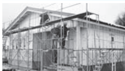
急ピッチで工事が進む藤沢墓園休憩室
