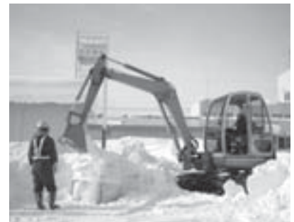
バックホーで雪を詰めます
