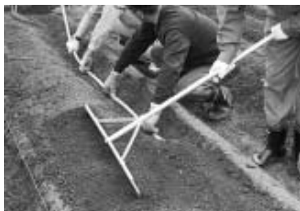
パイプの埋設作業
