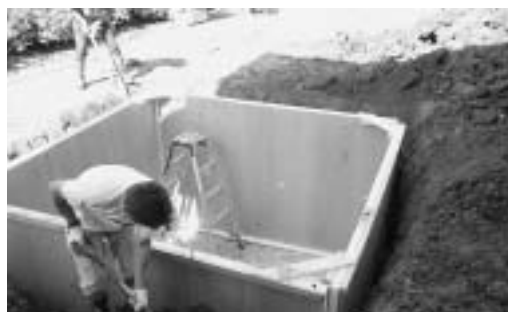
貯雪槽の製作
