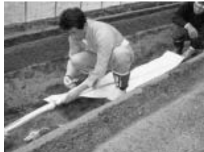
写真6 土中にパイプを埋設
