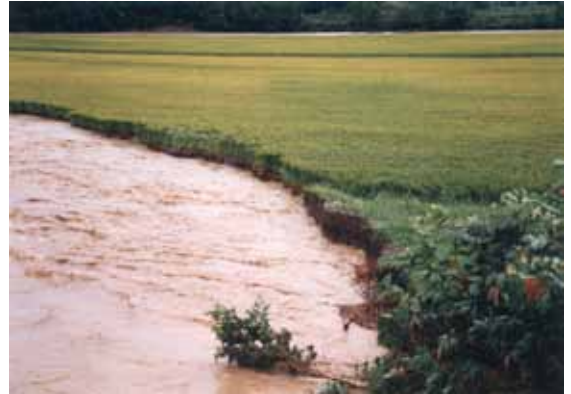
▲昭和63年 幌新太刀別川の氾濫で崩壊した水田 (恵橋からの撮影)
