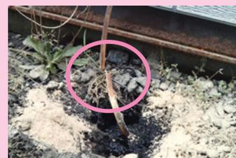
▲ 配管が切断され灯油が漏れている
